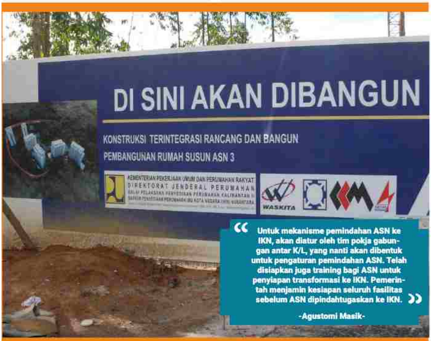
Gambar 7. Proses pembangunan rumah tinggal ASN di IKN per 7 Desember 2023
