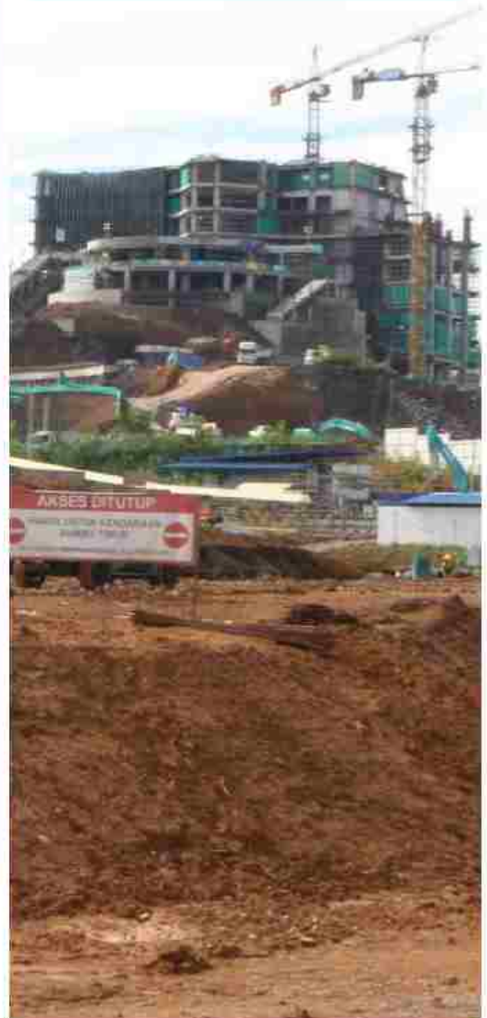
Gambar 6. Proses pembangunan gedung fasilitas di IKN per 7 Desember 2023
